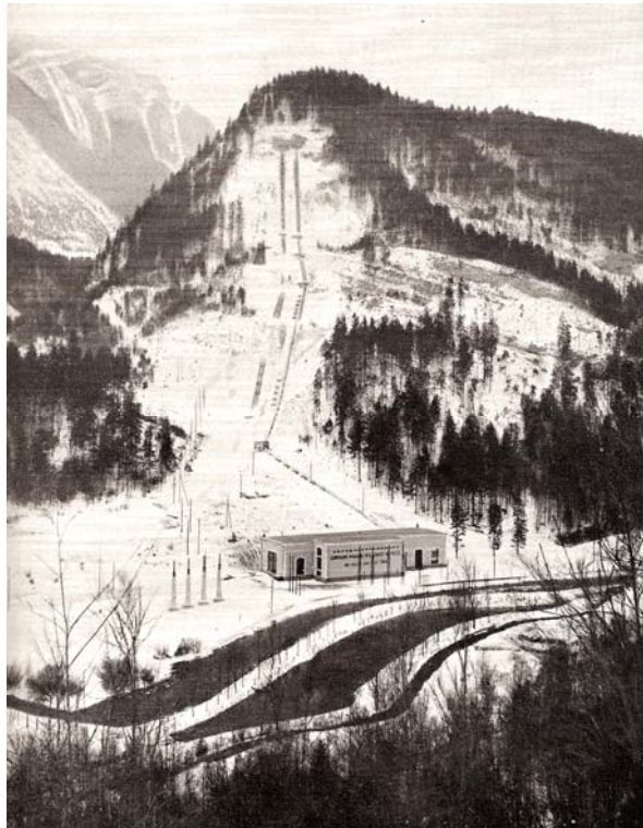
Vue générale de l'usine génératrice de La Dernier (1904)
