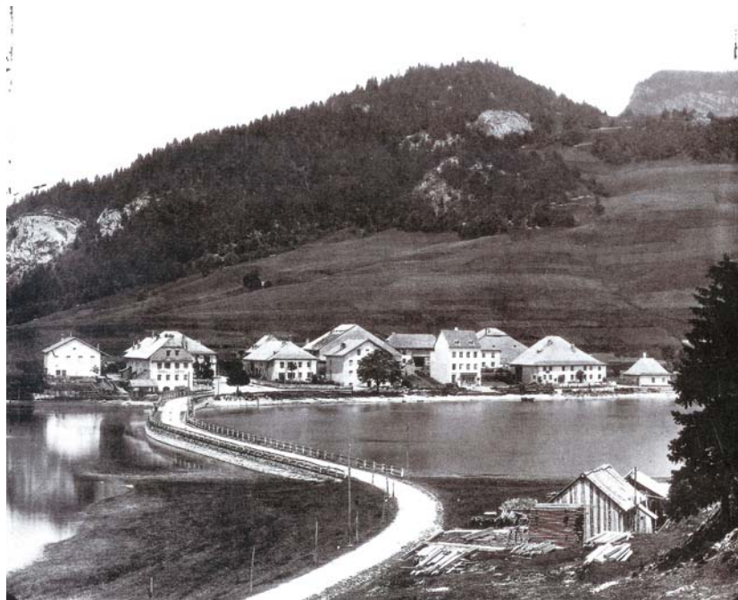
Le pont de 1838-1843 tel qu'on pouvait encore le voir dans les années 1880, fixé pour la postérité par le photographe Auguste Reymond.
